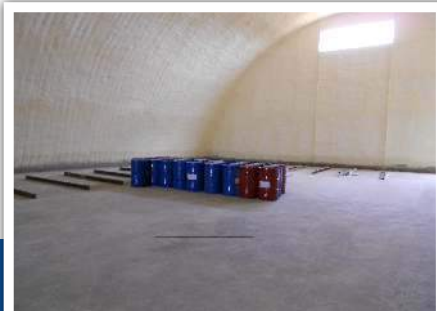
Так выглядит ангар, полностью утепленный пенополиуретаном
