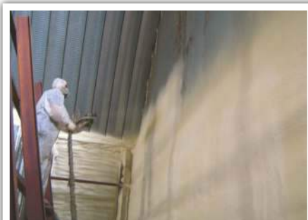
После полной полимеризации получается однородный слой
