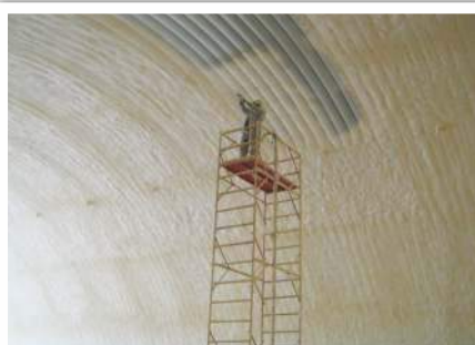
Для работы на высоте собираются строительные леса
