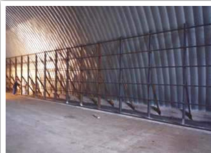
Монтаж конструкций вентиляционного канала
