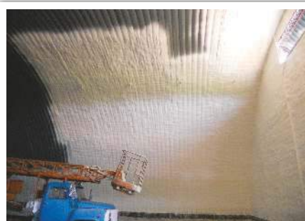
Для напыления ППУ на потолке используется автовышка
